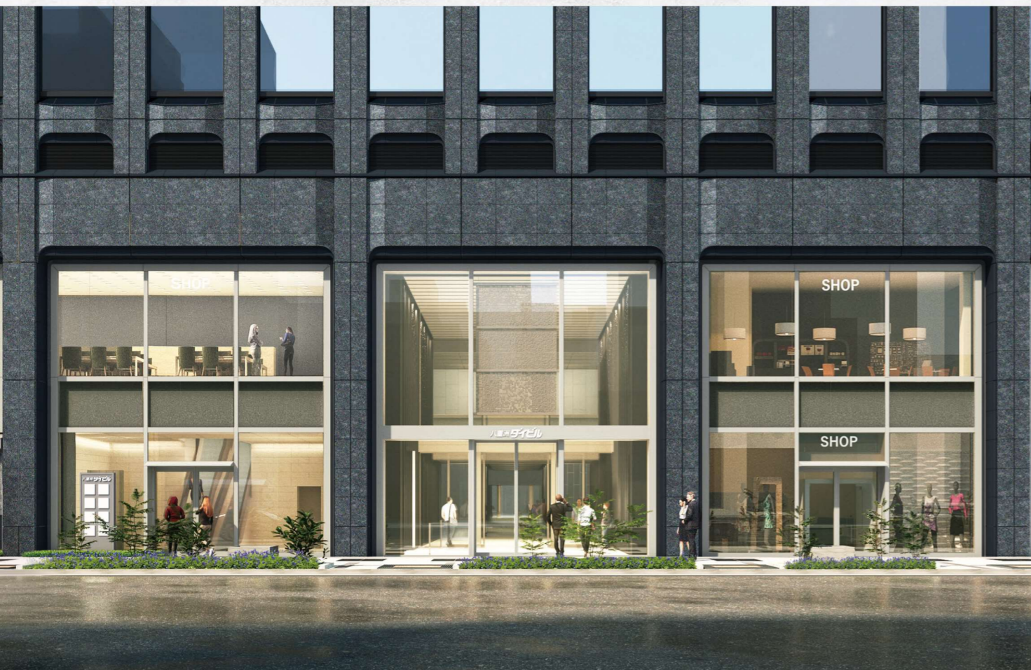
メインエントランス(外観)
