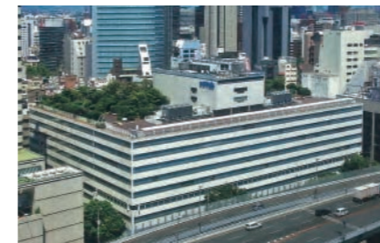
旧・新ダイビル外観
