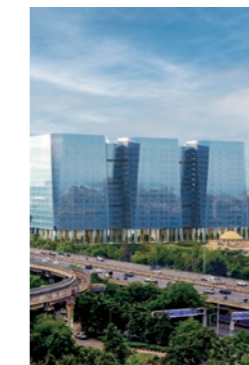
インド Atrium Placeプロジェクト デリー近郊・グルガム市中心地区におけるオフィスビル開発プロジェクト 2025年12月竣工予定
