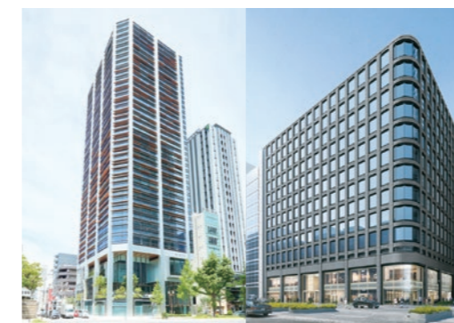
御堂筋ダイビル 2024年1月竣工 | 八重洲ダイビル 2025年中頃竣工予定
