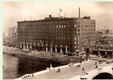
(旧)ダイビル本館
