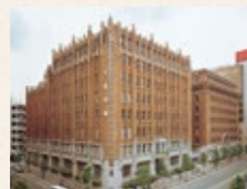
(旧)日比谷ダイビル (右:1号館/左:2号館)
