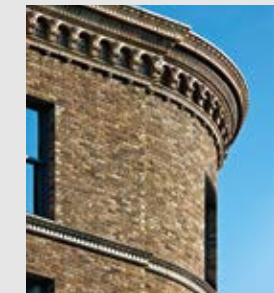
手作業で積みなおした15万個の煉瓦
