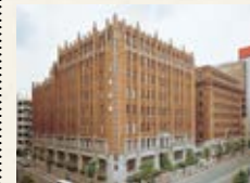
(旧)日比谷ダイビル (右:1号館/左:2号館)
