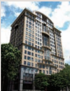
サイゴン・タワー
