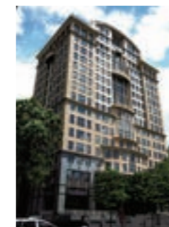
写真⑪ サイゴン・タワー
