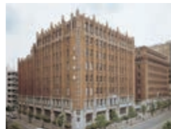
写真② (旧)日比谷ダイビル (右:1号館/左:2号館)
