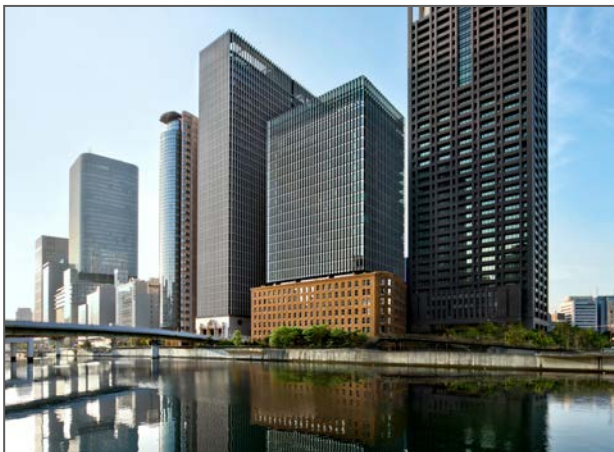
堂島川からダイビル本館を望む
