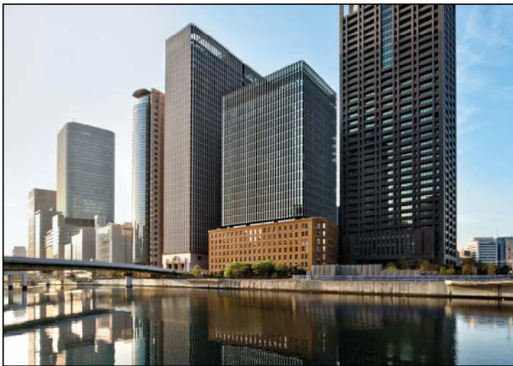
堂島川からダイビル本館を望む
