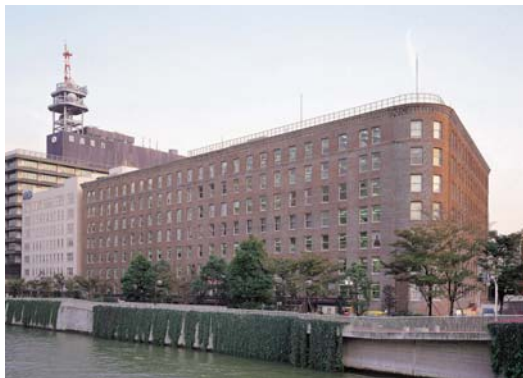
□ 旧「ダイビル本館」(手前) 外観
